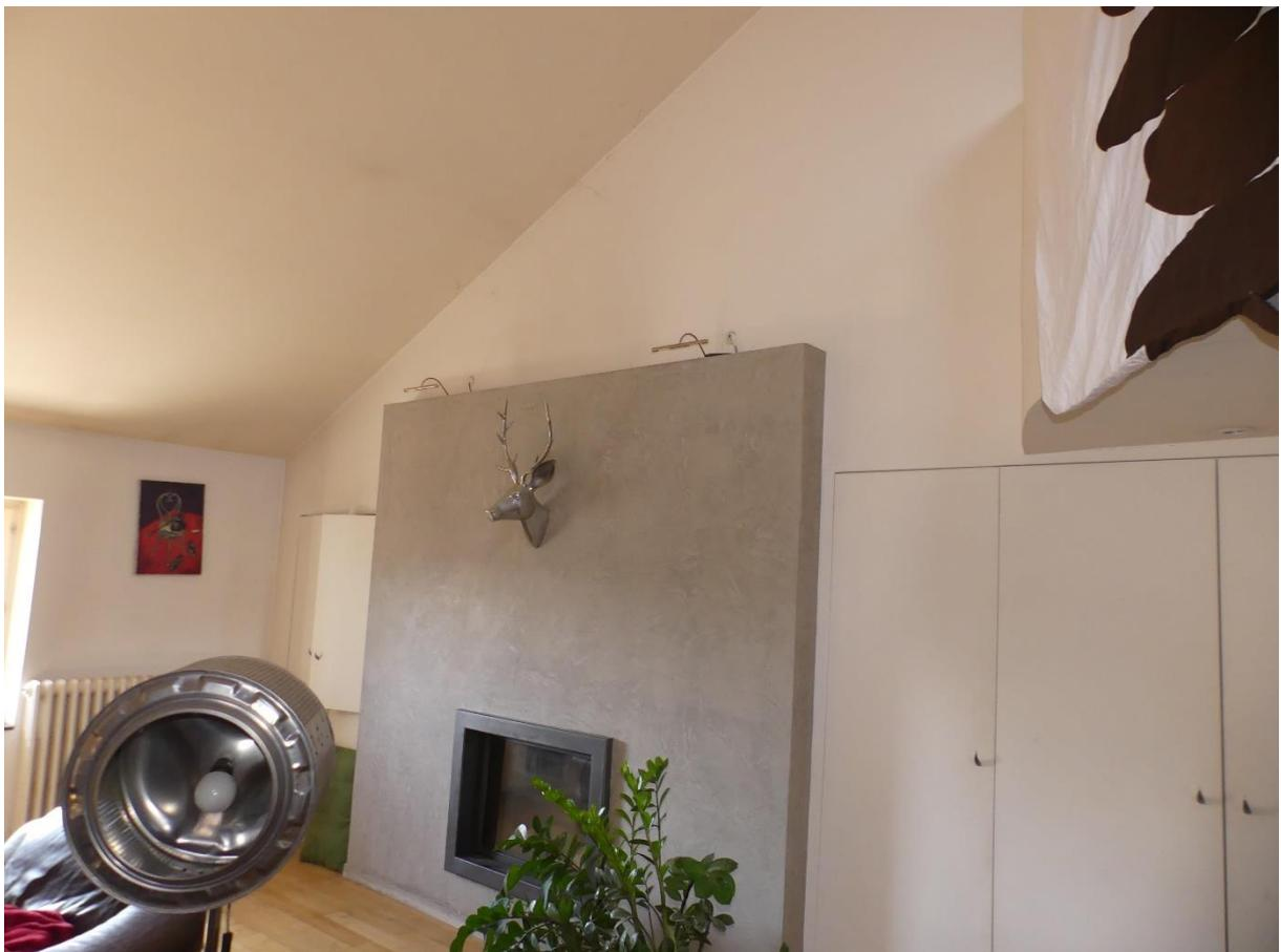
Je note l'implantation d'un insert, positionné dans une paroi en stuc. Celle-ci est en bon état général. De part et d'autre, j'observe des placards sur mesure.
