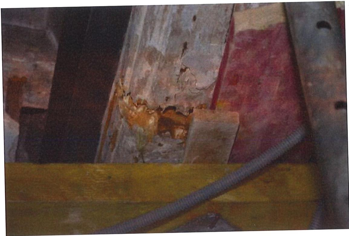
Des étais soutiennent la poutre maitresse en prenant appui sur un IPN scellé au Nord dans le mur de la chambre 1 et au Sud dans le bureau.
